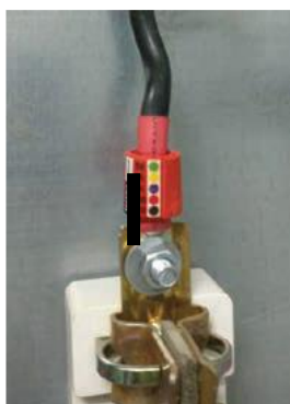
Рисунок 16. Пример системы, состоящей из термоактивируемой газовыделяющей наклейки и специализированного газового датчика
